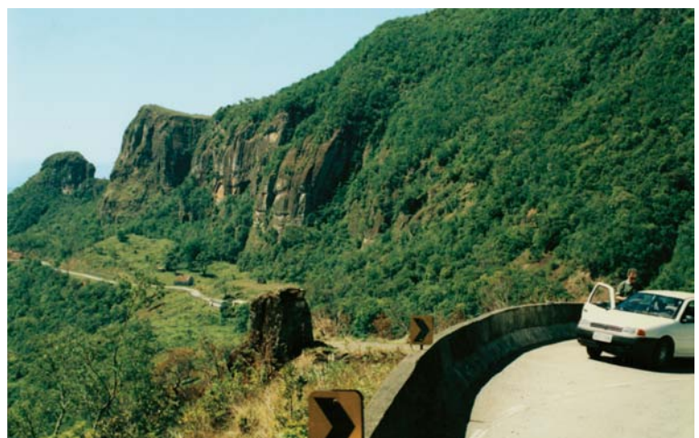
Figura 13 - Trecho da rodovia na altura dos pontos 14 e 15 (foto Wilson Wildner).
