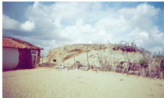
Figura 10 - Processo de ocupação desordenada com construção de casas sobre afloramentos de eolianitos na costa de Baleia-CE. Foto: A.M.Carvalho.
